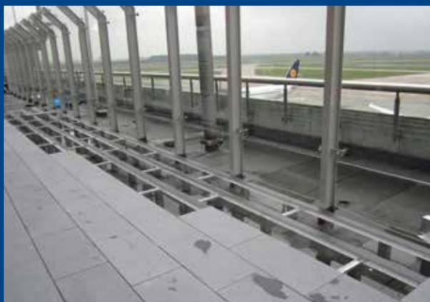
Das UK-FIX Verbundsystem ermöglicht u.a. eine stabile und großflächige Unterkonstruktion für z.B. Besucher- oder Hotelterrassen.
