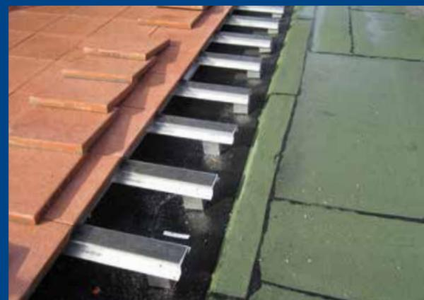
In Zusammenarbeit mit dem jeweiligen Objektstatiker kann ein Geländer direkt und ohne Bauteildurchbruch an die Unterkonstruktion UK-FIX angeschlossen werden.
