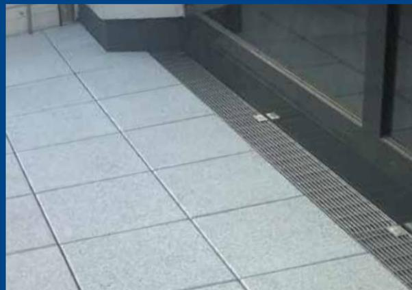
Barrierefreie Terrassenzugänge mit integrierten Ablaufsystemen sind durch die flexible Verlegehöhe von UK-FIX selbstverständlich.
